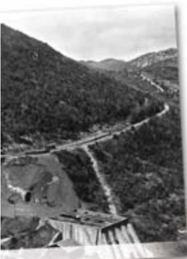
Le transport du minerai s'effectue au départ par charrette (dans les galeries, les chevaux côtoyaient les hommes) puis par locomotive électrique qui traîne les wagonnets (dont un modèle est exposé devant la salle du Recoux) jusqu'à un câble aérien de 1 600 m qui transporte la bauxite en gare où une trémie peut recevoir 5 000 t.
